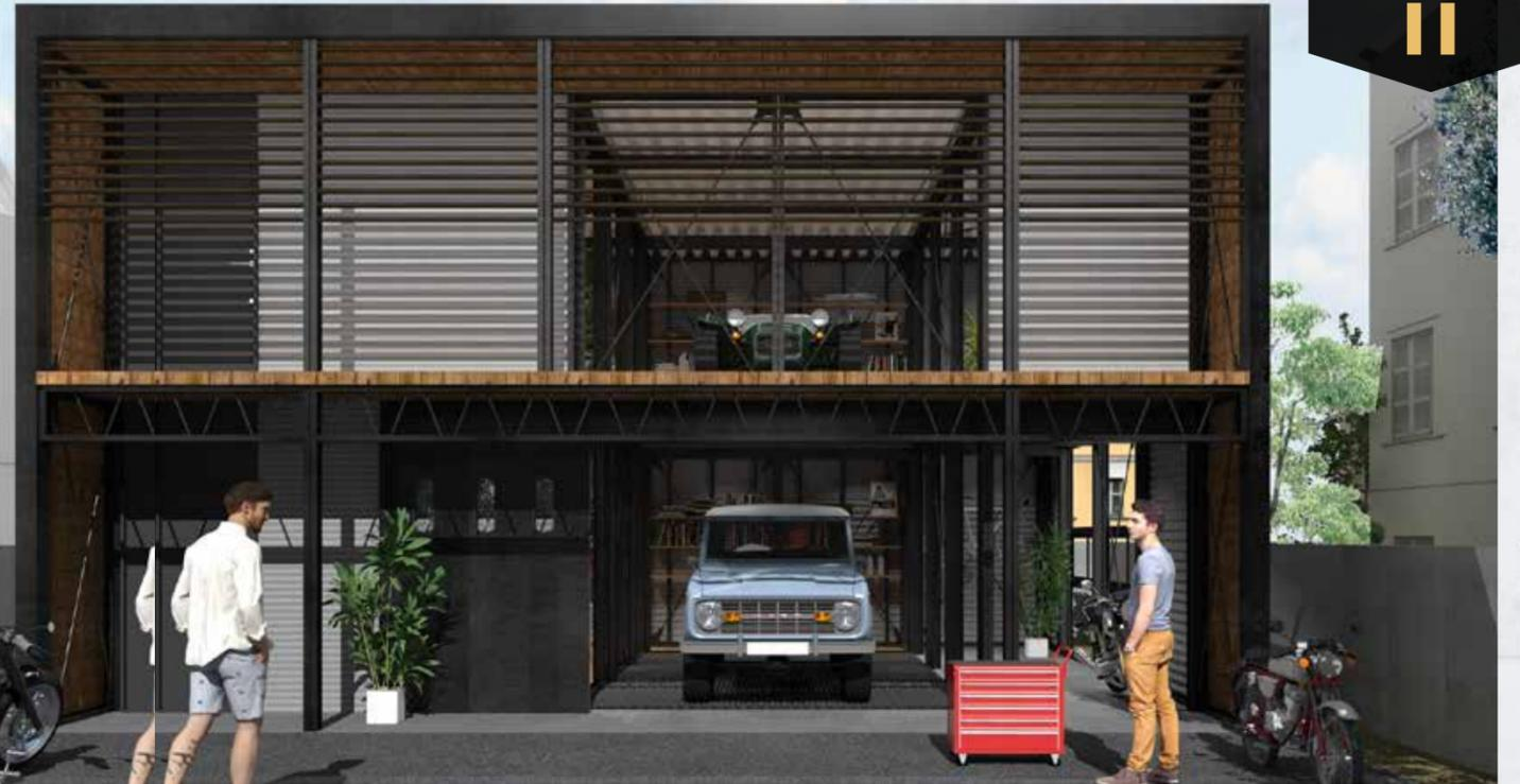
この建物は、モーターライフを人生の中心に据える男にとって、必要かつ十分な面積であることが図面からよく読み取れます。1Fが3.5スパン×5スパンで17.5坪、総2階で35坪のインナーガレージ住宅。クルマ2台とバイク2台を美しく格納する合理的プランで、男が男として生きていくためのソリッド感をテーマに、必要な物だけを深く抽出した、都会で生きていくためのアジトともいえるモノ。向かって左側の上下階の居住スペースから、ガレージ空間がすべて見渡せる空間空間性、この家の最大の特長で、ガレージと居住スペースの分離を回避して、程よく一体化を演出しています。
