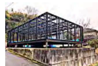
兵庫県相生市で建設中のSpiky-LGSの骨組み写真。重厚感のある鉄骨骨組みがフワリと浮かび上がっている様子は更に印象的で、この段階で建物への愛着のバロメーターは振り切っています。床には50mmの断熱材と一体になったコンクリート板を使用。
