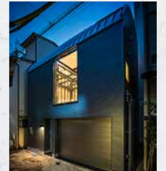
外壁には、亜鉛とアルミニウムの合金「ガルバリウム鋼板」という耐久性のある素材を使用。断熱材と一体になった外断熱方式で、鉄骨の柱の外側に設置します。建物の印象をシャープにするデザイン上のメリットに加えて、長い間メンテナンスフリーの高耐久素材。
