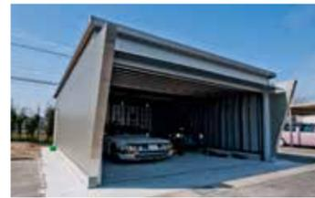
この住宅の原型となっているのは、デイトナハウスの規格ガレージ「GARAGE-D」。外壁は断熱材と一体になったガルバリウム鋼板。スタイリッシュな外観と、長い時間の滞在も可能にする居住性の良さがウリです。内部はもちろん艶消しブラックの粉体塗装鉄骨です。
