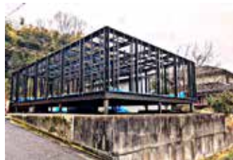
兵庫県相生市で建築中のSpiky-LGSの骨組み写真。重厚感のある鉄骨骨組みがフワリと浮かび上がっている様子は更に印象的で、この段階で建物への愛着のバロメーターは振り切っています。床には50mmの断熱材と一体になったコンクリート板を使用。
