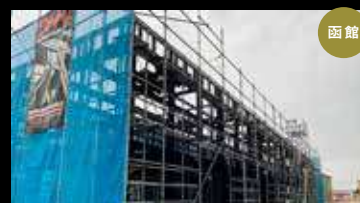
函館市北美原に建築中のGLB。3×4スパンの「WHITE BASE」を採用したゆったりタイプの6世帯です。
