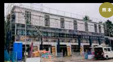
熊本県大津町に建築中のGLB。2×4スパンの「BLACK HANGAR」が6世帯(内1世帯は3×4)です。
