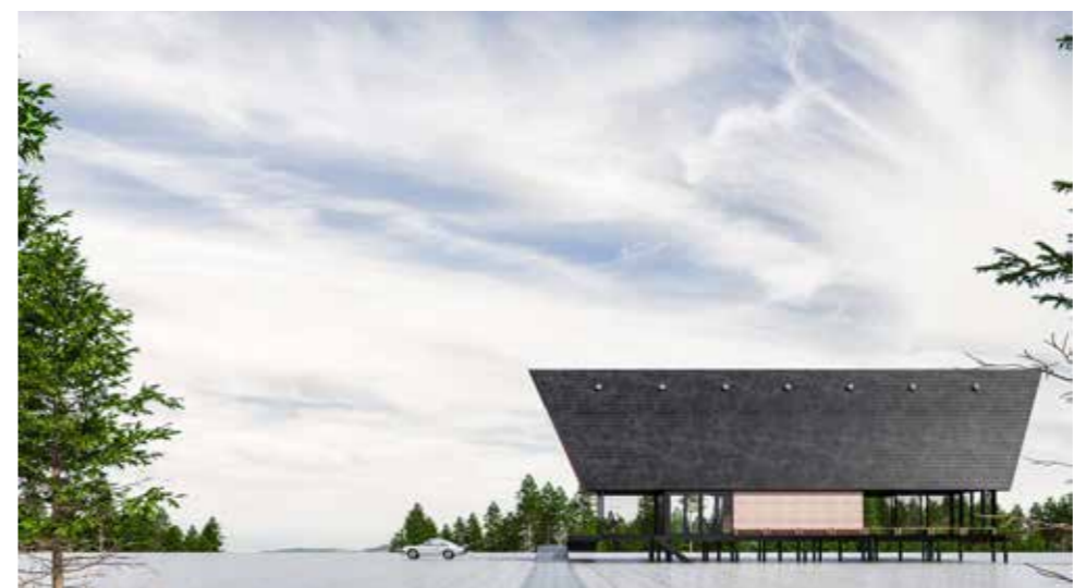
建物は高床式で一旦ふわりと浮かび上がらせています。更に、鉄骨メンバーが細いため、構造部分が視覚的にゼロ記号化し、あたかも中央部の白木の箱で巨大な合掌を支えているかのような印象のシルエット。神事のお供え物は三方（さんぼう）と呼ばれる台に置かれるが、建物フォルム自体が巨大な三方を連想させています。
