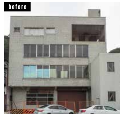
改修工事前の建物の全景。白いタイルの壁が老朽化して、風景に埋没していた。特徴のないファサード。
