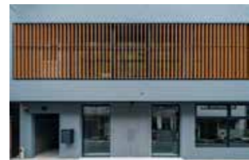
建物裏側に位置する玄関部分の外壁写真。タイルの壁を樹脂モルタルで固め、その上をモルタル補修して、グレーに塗装する一方で、開口部には木製ルーバーを施しています。
