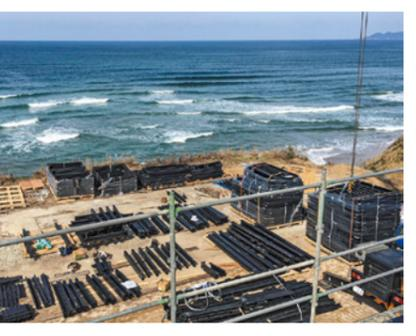
まるで実物大のプラモデルのパーツのように海岸線に整然と並べられたLGSシステム建築の鉄骨パーツ類。1.8m×2.7mの長方形のパネルは、ボルトで接合されることにより、はじめて「柱」としての機能を受け持つのです。つまり組み立てによって「生まれ変わる」ということなのです。
